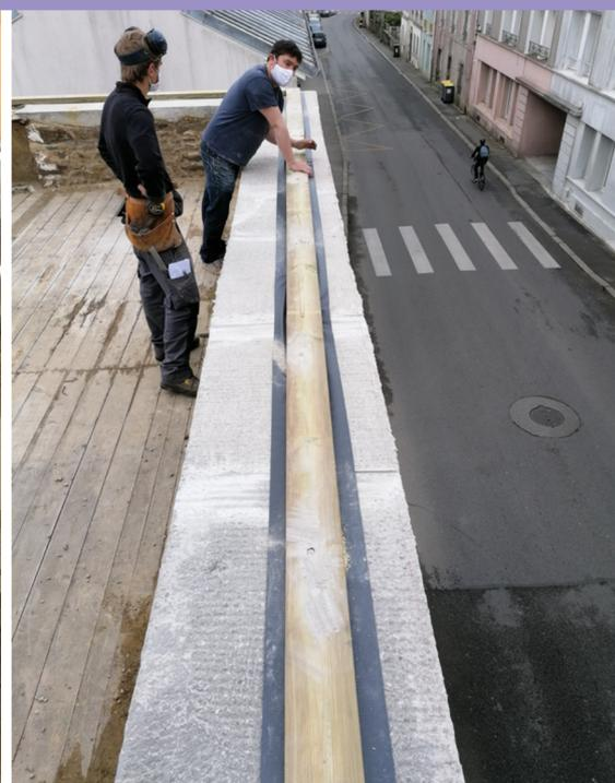
Arrase de maçonnerie et mise en place de la panne sablière
