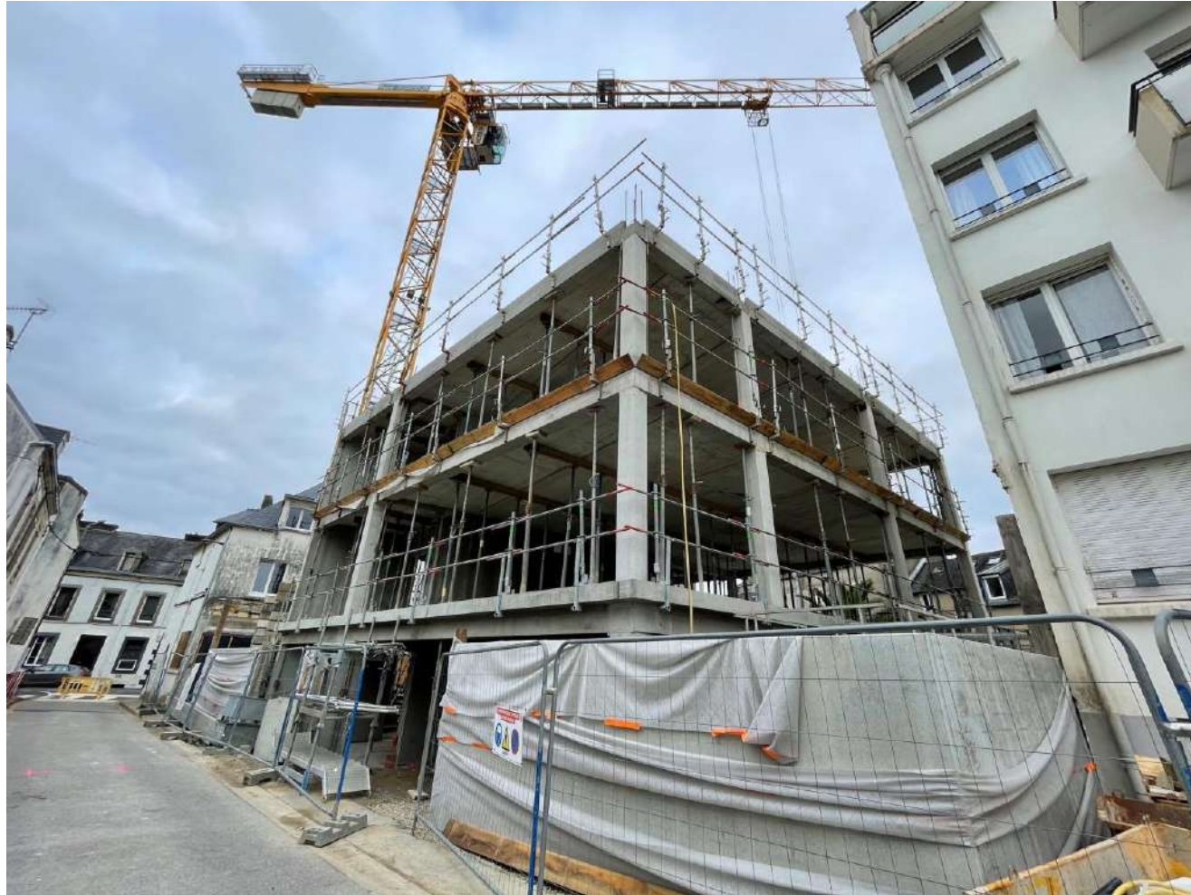
Béton en prémur pour l'inertie thermique
