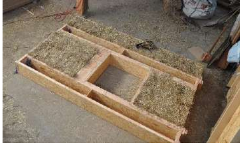
Mur bois préfabriqué isolation paille
