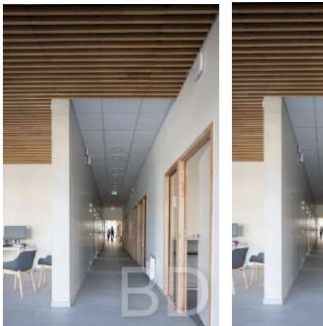
Béton en prémur pour l'inertie thermique
