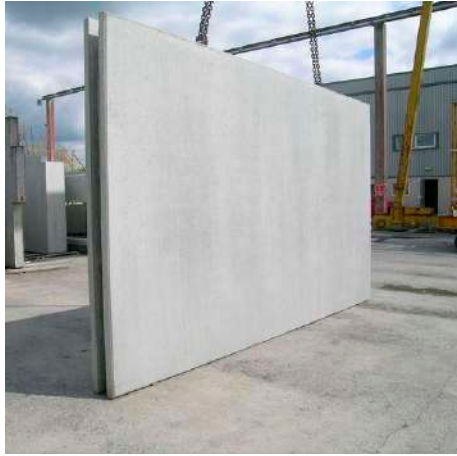
Béton en prémur pour l'inertie thermique
