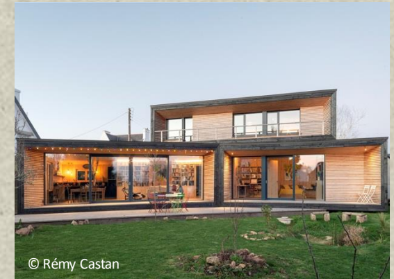
Maison Koad Du Combrit (29), 2019 Architecte : Alice Paméla Architecte BET : Batitherm Conseils
