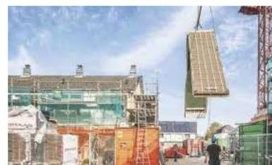
→ Taille du module de toiture à adapter à la longueur de l'existant, nature de la couverture à choisir, adaptation de l'épaisseur d'isolant en fonction de l'éventuelle isolation existante...
