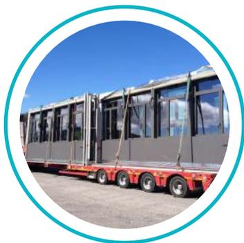
La préfabrication hors site doit intégrer l'organisation **du transport** de l'usine jusqu'au chantier, en cherchant à améliorer son efficacité en termes de coûts et de délais. Les caractéristiques et dimensions des éléments hors site doivent donc être pensées pour viser la **meilleure adéquation entre facilité de transport et rapidité de mise en œuvre.**
